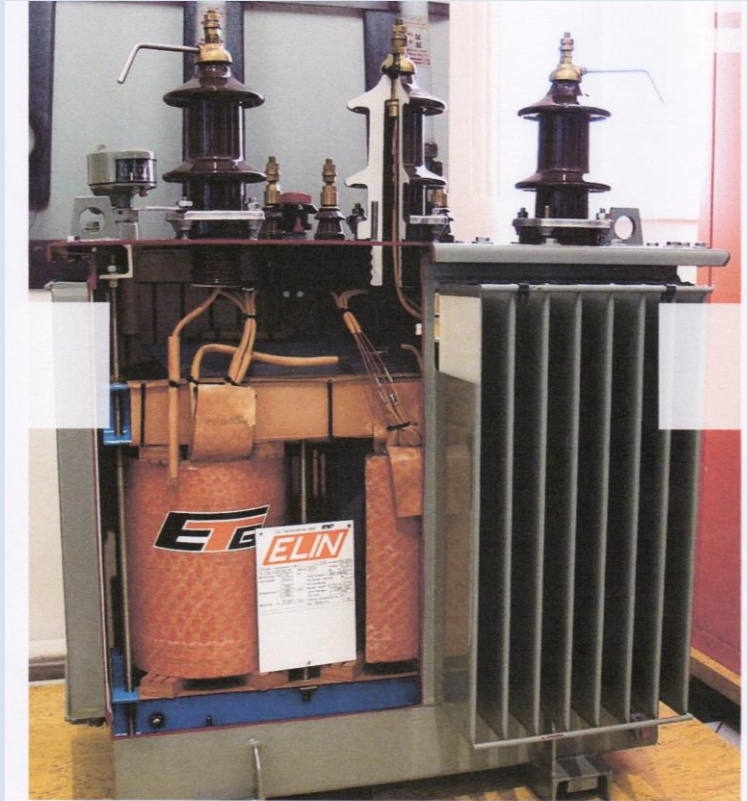
Transformateur de distribution
